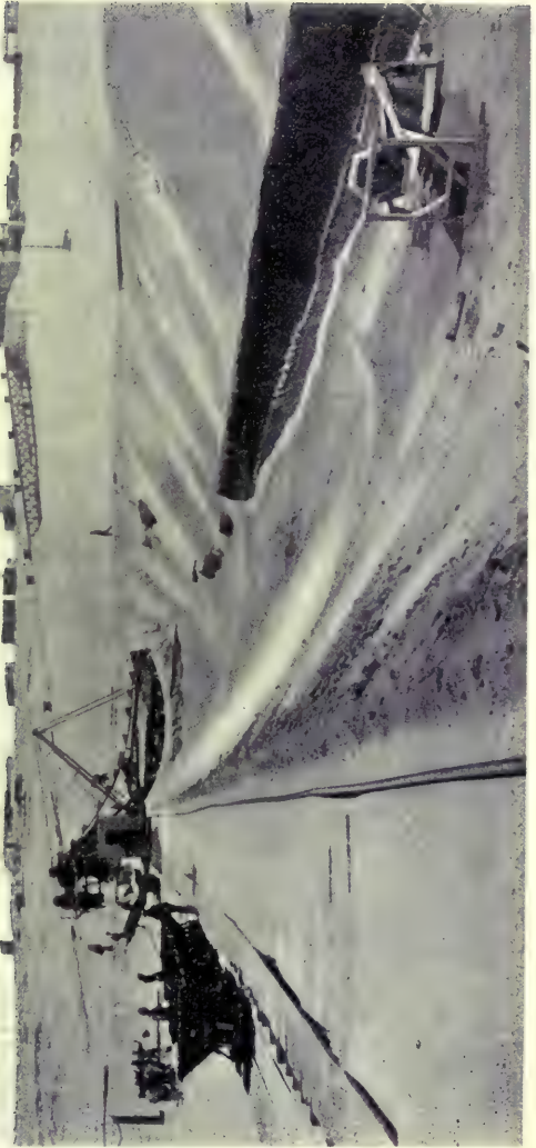
VEREINIGTE DIAMANTMINEN, LUDERITZBUCHT. BUCKET DREDGER AND WIRE ROPE RAILWAY ON THE
